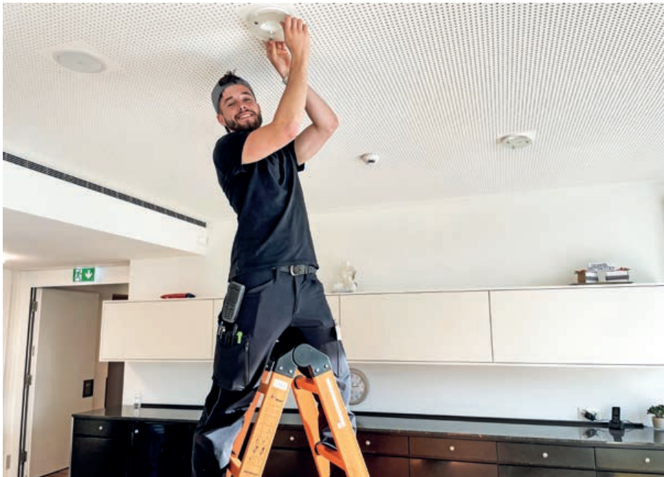
Stepan Vrhotka bei der Umrüstung auf LED-Leuchtkörper im LaVita.
